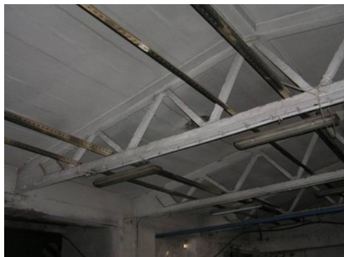
Obr. 4.71 Příhradový vazník - železobetonový
