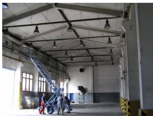
Obr. 4.77 Železobetonové vazníky s ocelovými prvky
