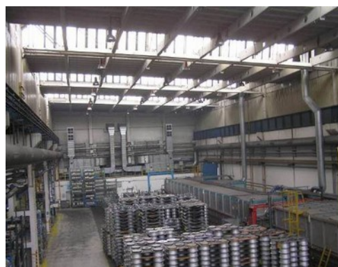
Obr. 4.79 Šestilodní hala, 204 x 144 m (1961- 1963). Železobetonová montovaná konstrukce, osová vzdálenost sloupů 12 x 24 m, výška 15 – 16 m
