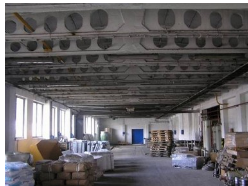
Obr. 4.72 Prolamovaný vazník - železobetonový
