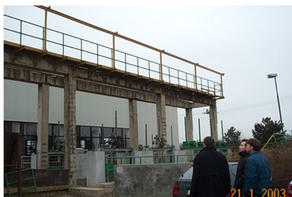
ŽB. Jeřábová dráha v ČOV Rám s klouby o čtyřech polích
