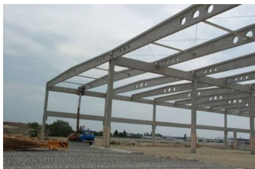
Obr. 4.59 Konstrukce montované haly
