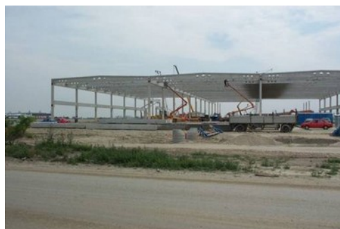
Obr. 4.59 Konstrukce montované haly
