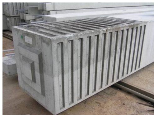
Obr. 4.54 Úprava sloupu v patě – vetknutí sloupu do kalichu
