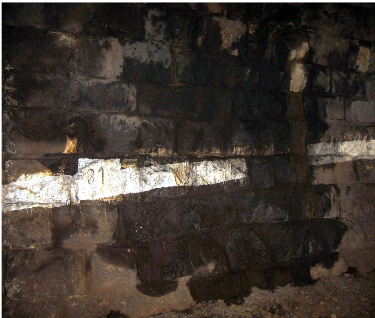
Obr. 4.7 Plošná zavlhllost - matná tmavá plocha, těžko identifikovatelný zdroj přítoku
