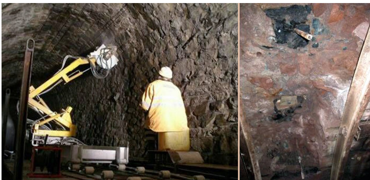
Obr. 4.24 Řezací fréza pro odbourání vrstvy do 100 mm, vpravo vybourání kamenné obezdívky na hl. 400 mm
