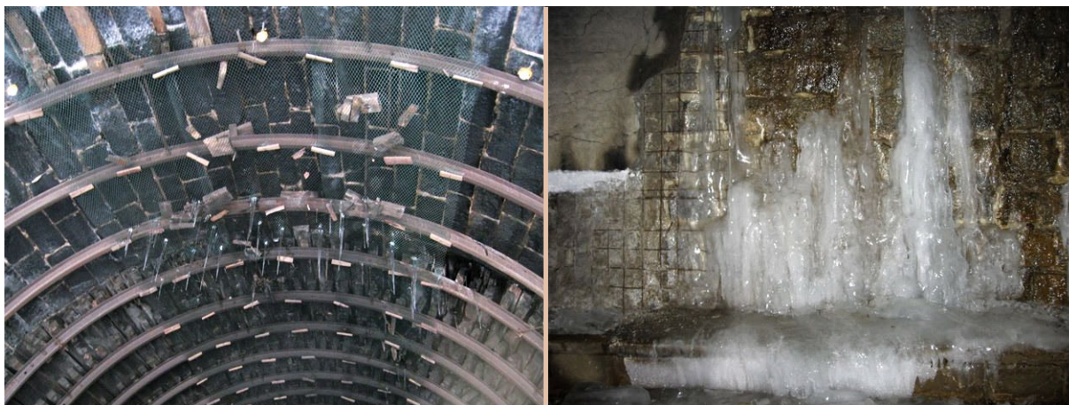
Obr. 4.2 Rampouchy a ledopády ohrožující provoz v tunelu
