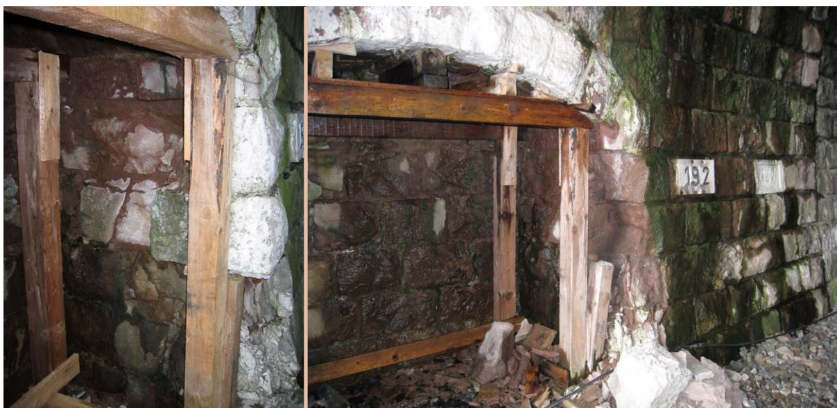
Obr. 4.14 Borcení obezdívky nouzového výklenku - dočasná řešení podepřením
