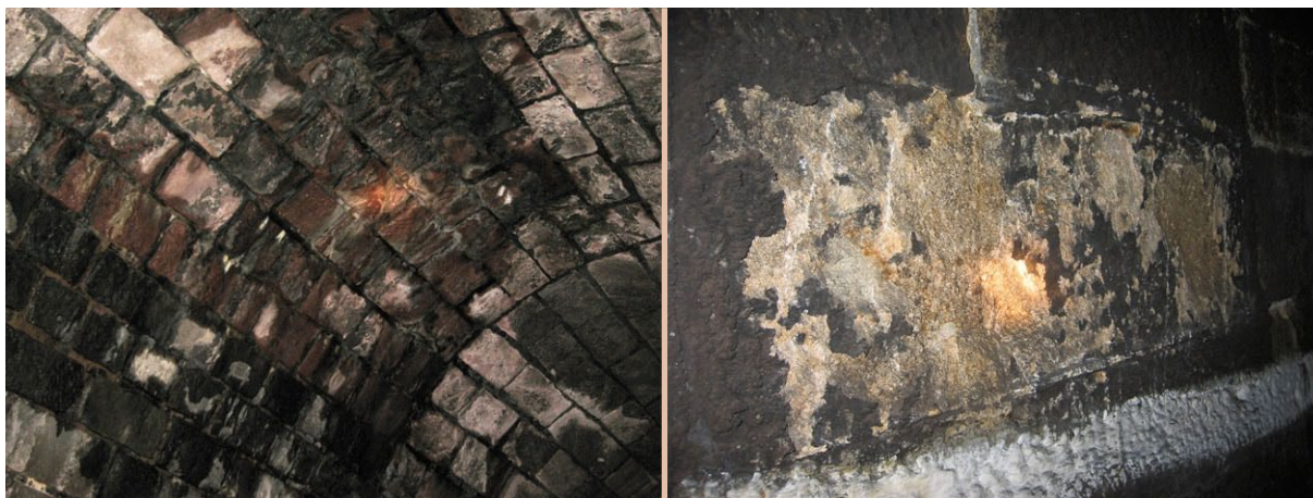
Obr. 4.37 Povrchová degradace materiálu ostění
