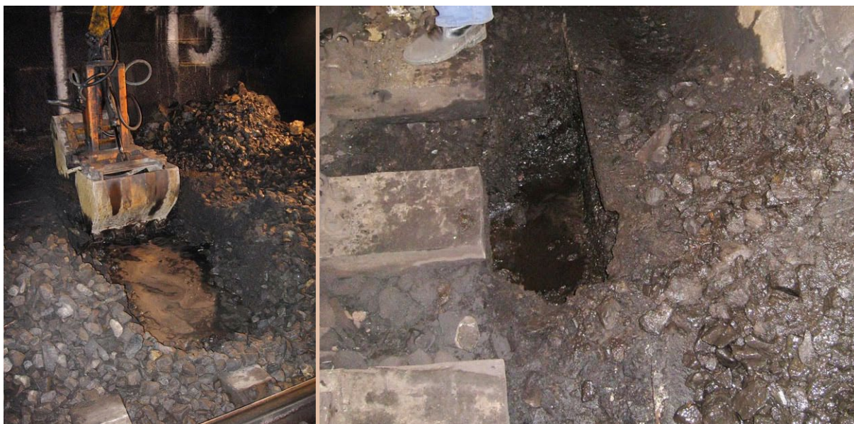
Obr. 4.12 Kopané sondy - zavodnění kolejového lože
