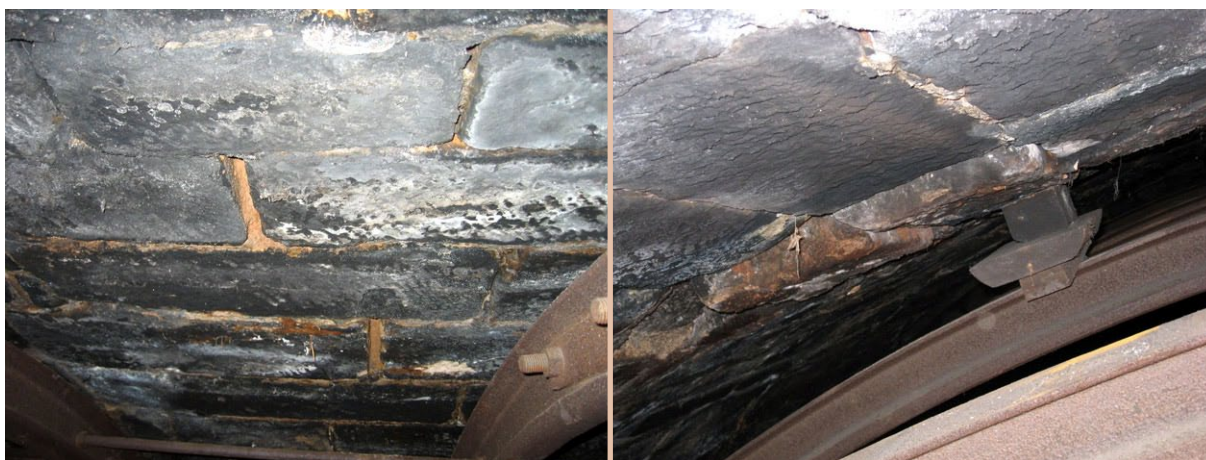
Obr. 4.26 Degradace spárování v kamenné obezdívce
