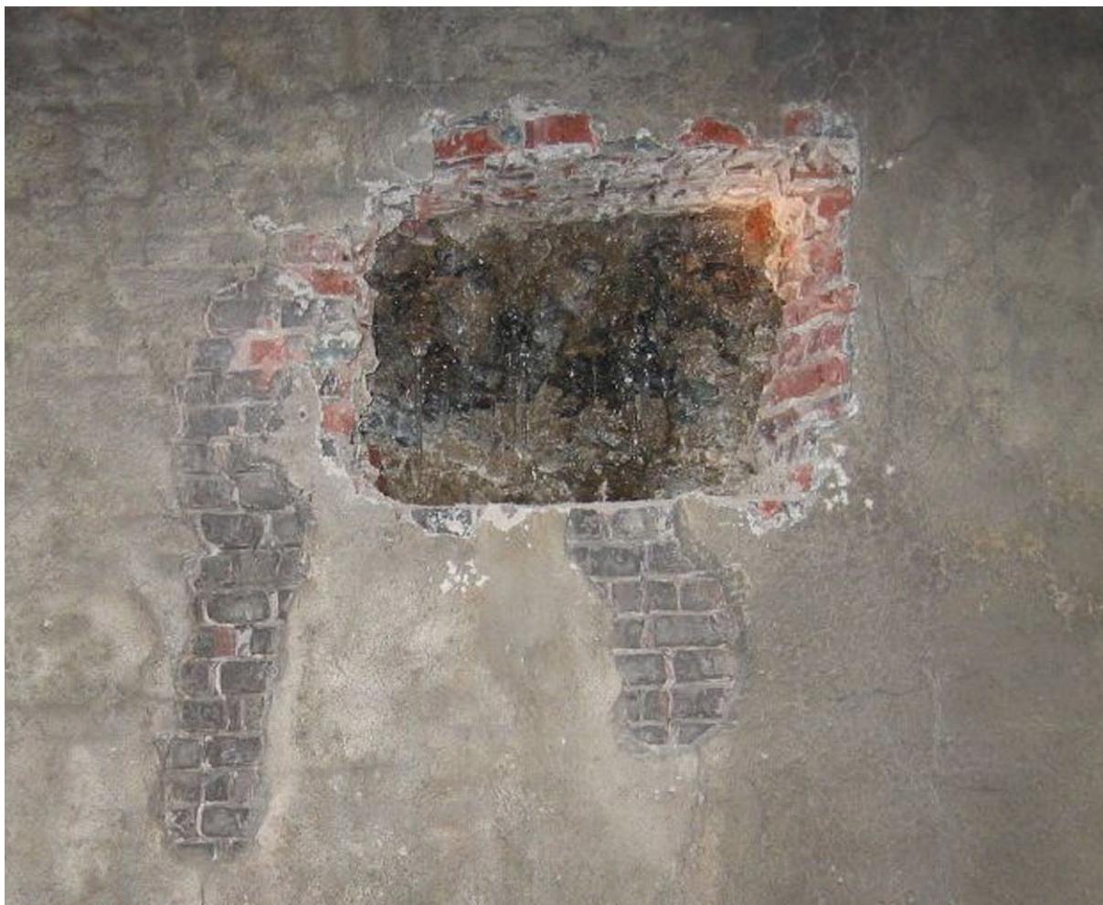
Obr. 3.8 Kopaná sonda přes ostění
