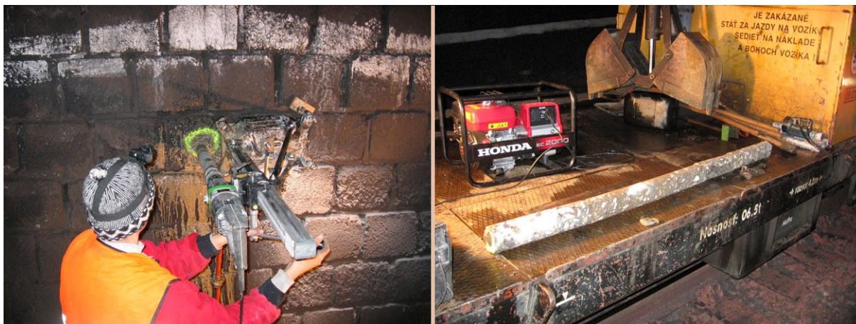
Obr. 3.13 Odběr jádrových vrtů z ostění tunelu
