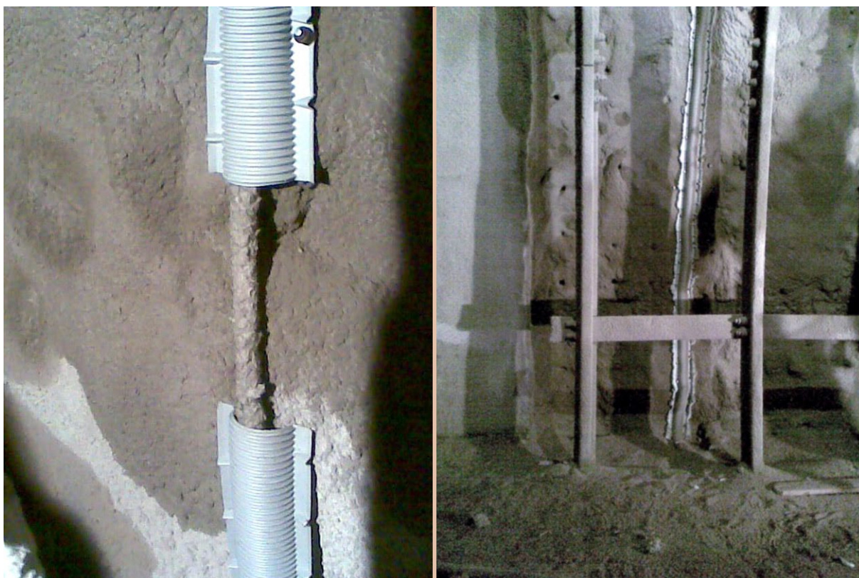
Obr. 4.4 Omega svodnice pro svedení jednoho lokálního výronu vody
