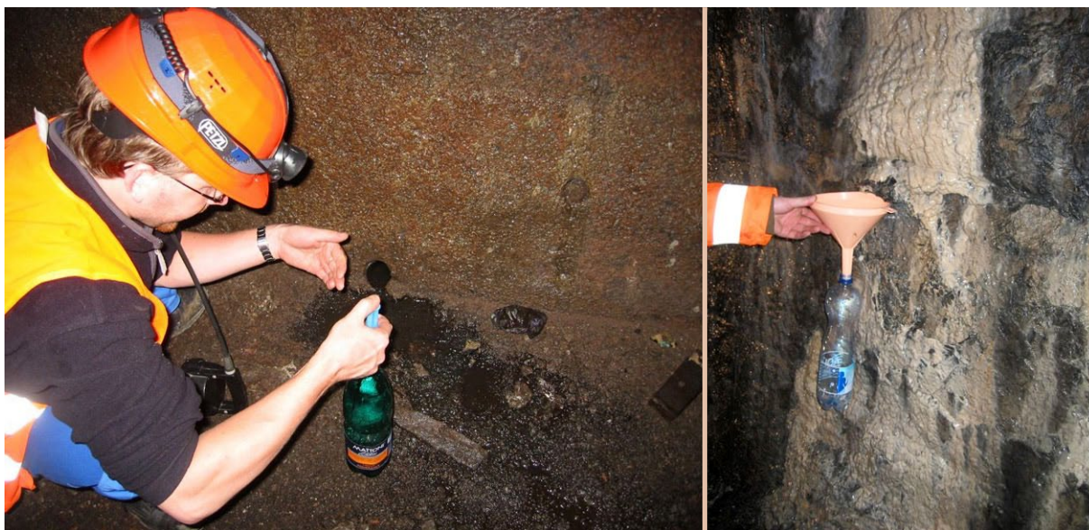
Obr. 3.18 Odběr vzorku vody z vrtu v patě ostění injekční stříkačkou
