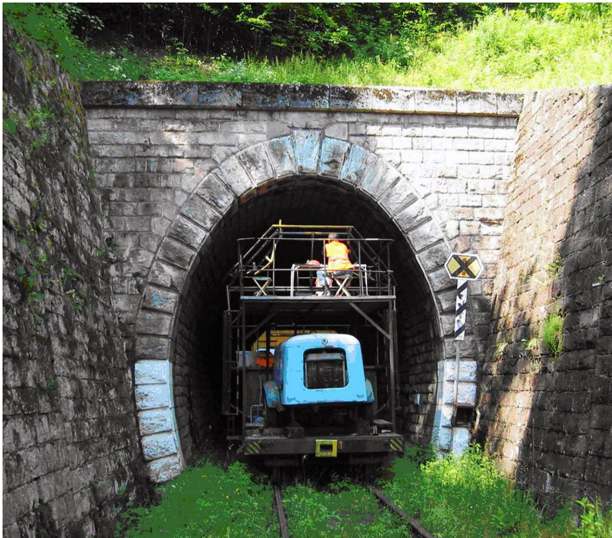
Obr. 3.1 Pracovní plošina s obrysnicí (SŽDC)
