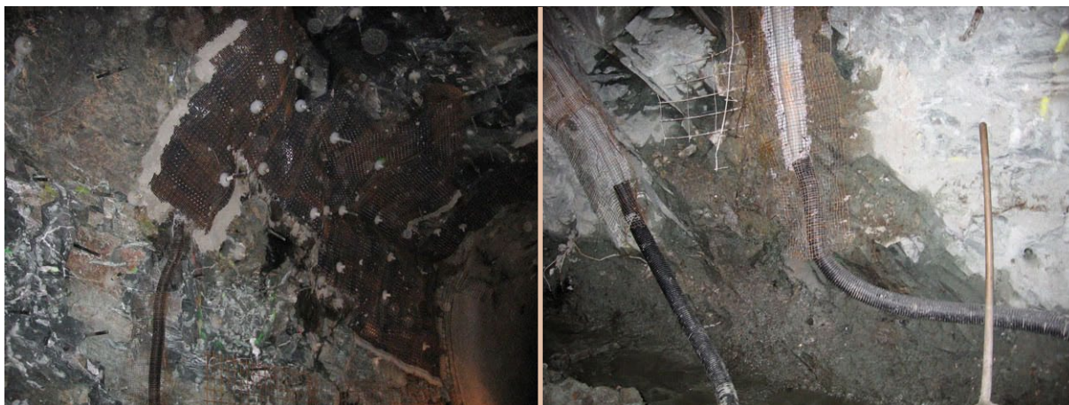
Obr.4.5 Svodnice přímo na povrchu výrubu - kombinace nopové fólie a omega svodnic, napojení do drenáže
