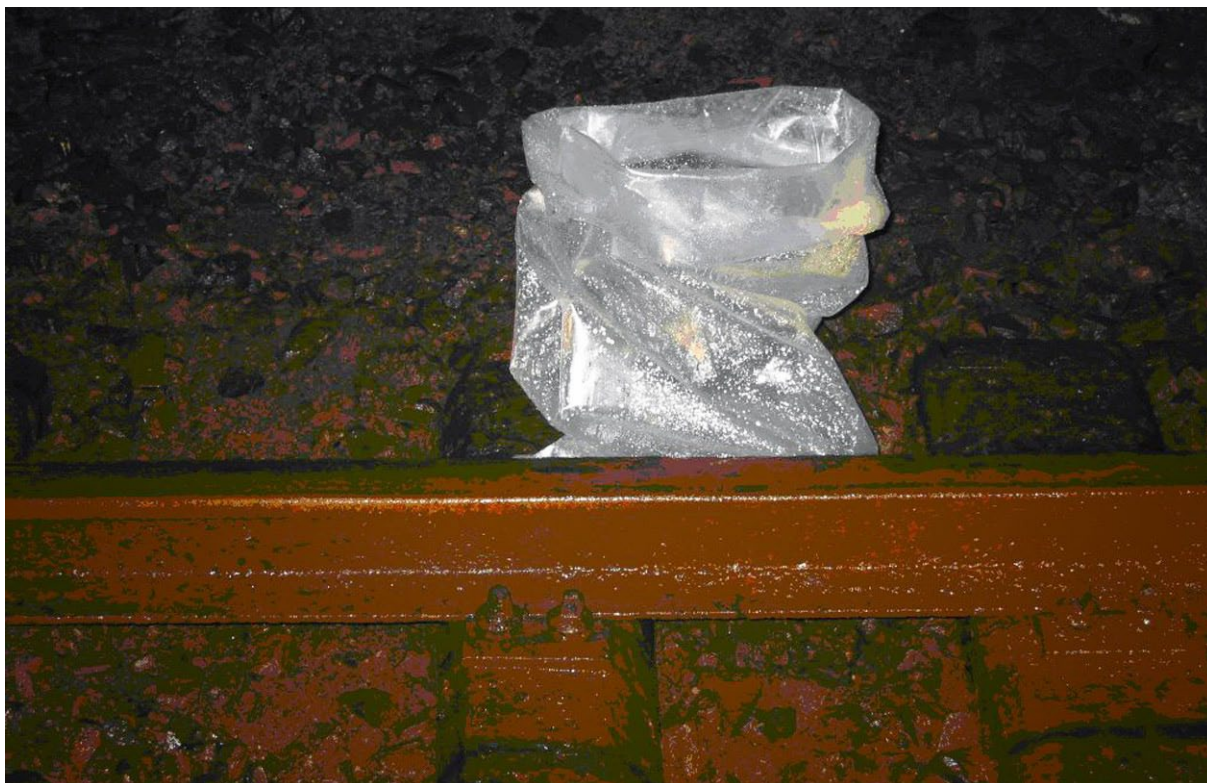
Obr. 3.19 Odběr vzorku vody kapající z vrchlíku do igelitového pytle
