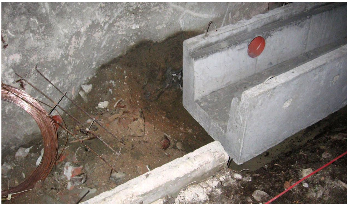
Obr. 4.13 Nové odvodnění tunelu z atypických prefabrikovaných žlabů
