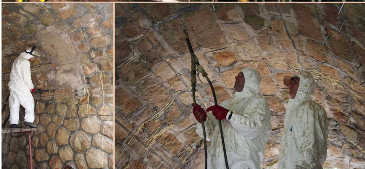
Obr. 4.36 Injektáž trhlín v kamenné obezdívce
