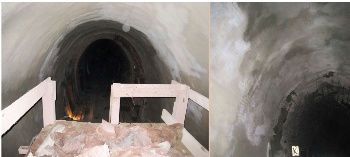
Obr. 4.25 Nové ostění se zvětšením světlého profilu
