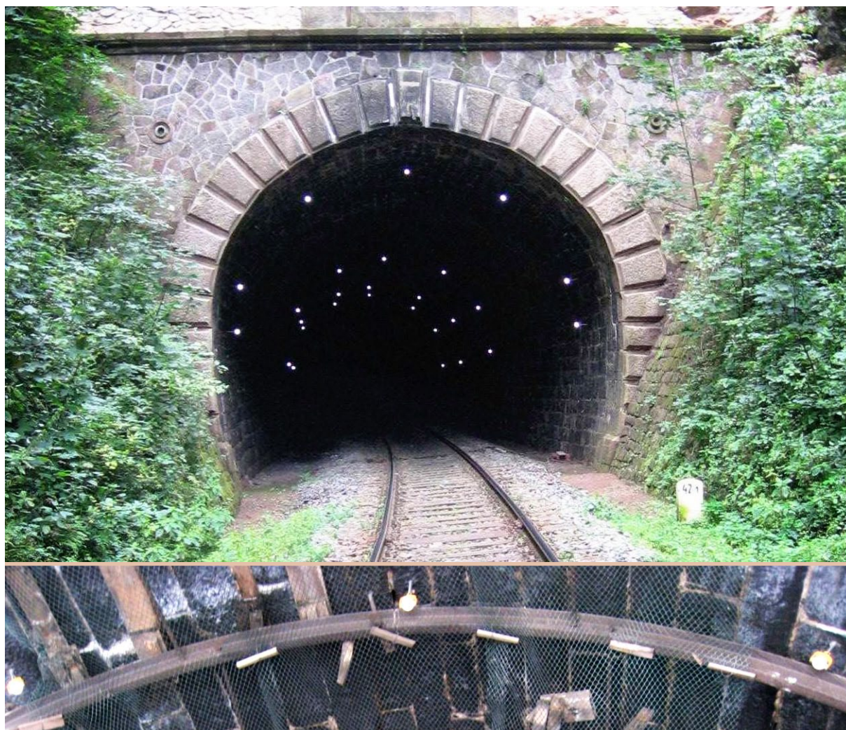
Obr. 7.1 Konvergenční profily - sledování deformací ostění během realizace a po dokončení stavby
