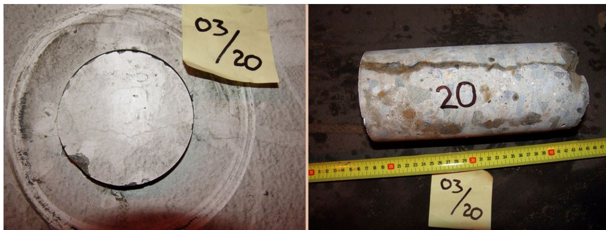
Obr. 4.34 Trhlina - na povrchu vlasová, po tloušťce ostění se rozšiřuje, zjištěno až jádrovým vrtem
