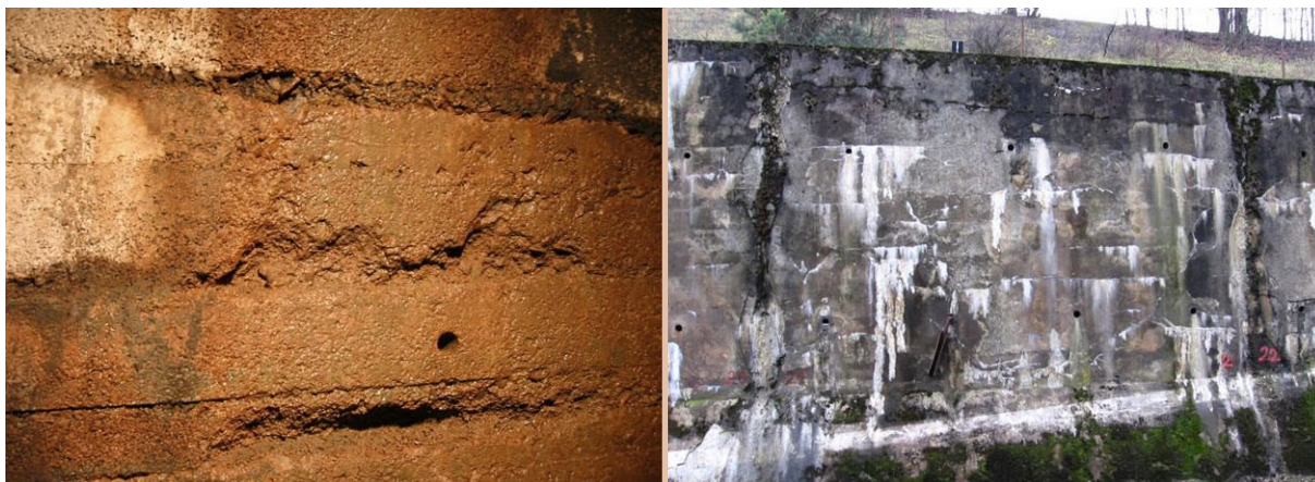
Obr. 4.39 Hlubková degradace materiálu ostění
