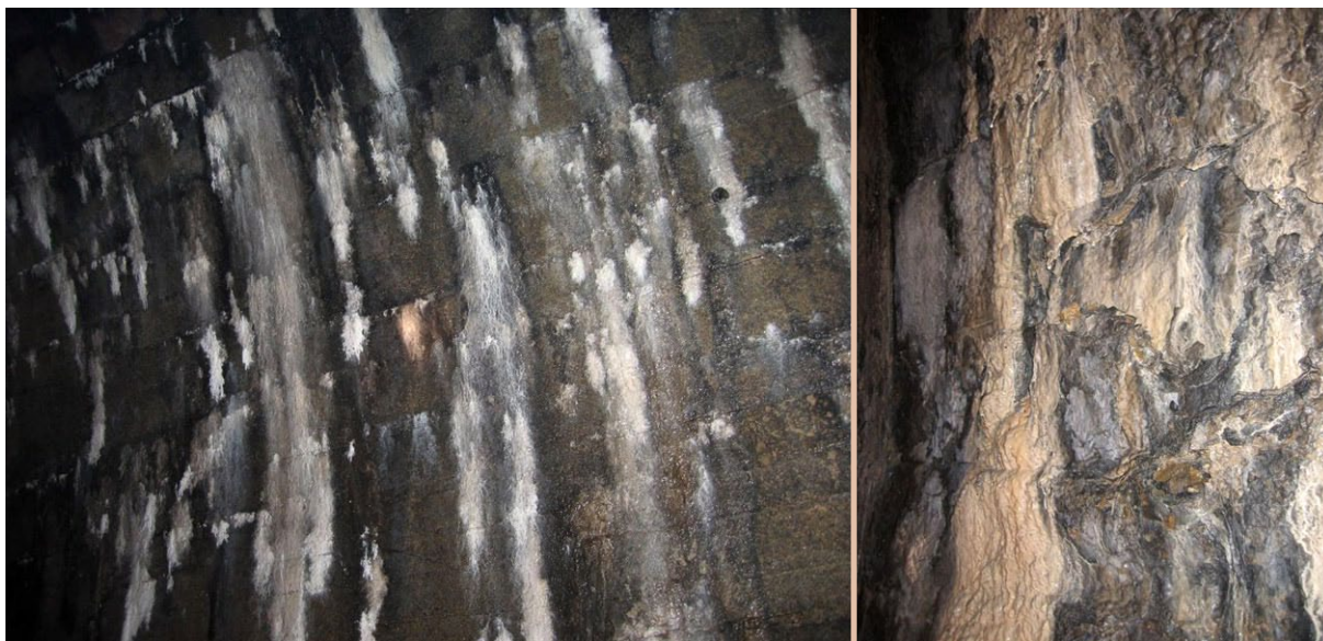
Obr. 4.8 Výluhy (výkvěty) na povrchu tunelového ostění (vlevo betonové, vpravo kamenné ostění)
