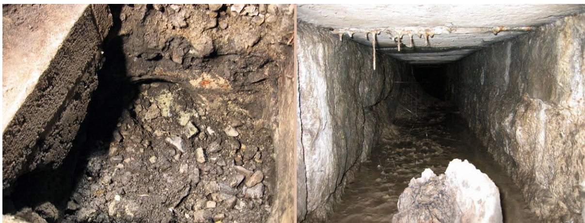
Obr. 4.11 Zanesení odvodňovacích zařízení pod komunikací
