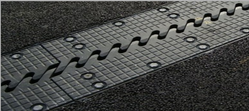
Hřebenový mostní závěr firmy REISNER & WOLFF.
