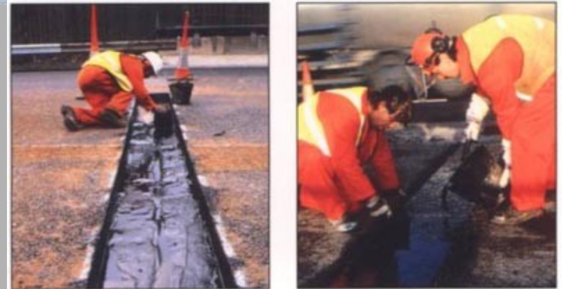
Elastický zálivkový mostní závěr firmy REISNER & WOLFF.
